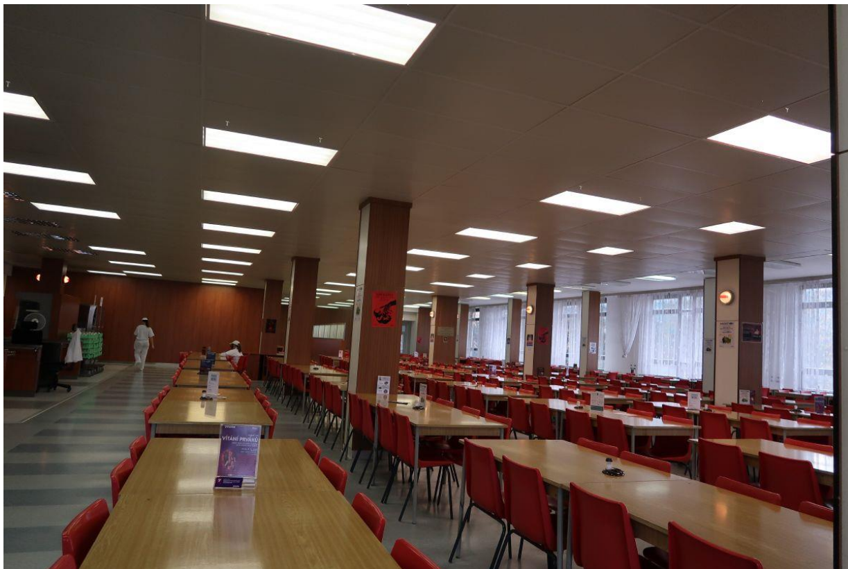
Jídelna (2.NP) – osvětlení vestavěnými zářivkovými svítidly
