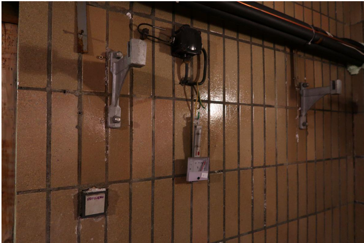
Chladírny – instalace na povrchu, nefukční vypínače
