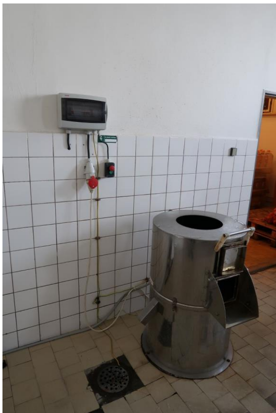
Podružné rozvaděče – doplnění ochrany proudovými chrániči
