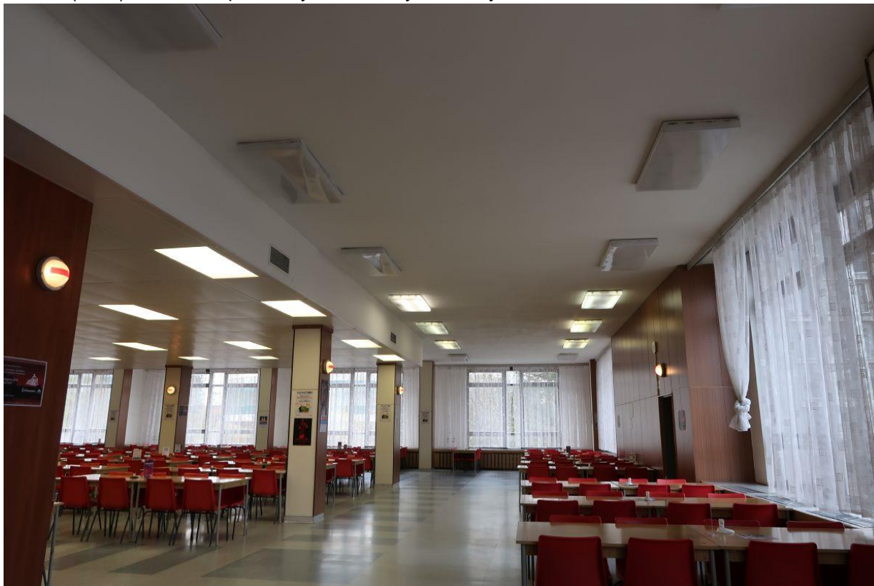
Jídelna (2.NP) – osvětlení přisazenými zářivkovými svítidly
