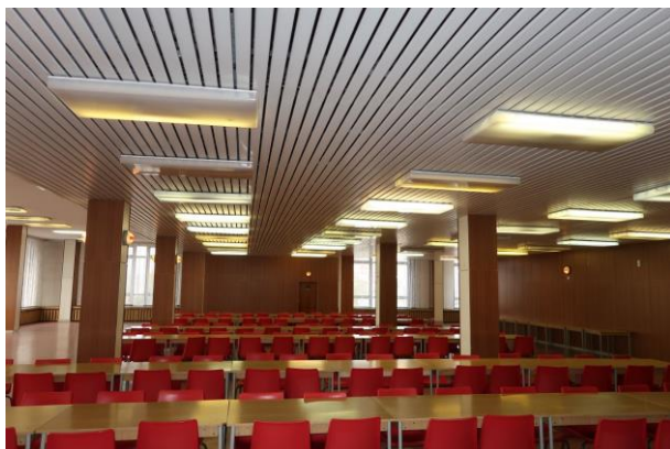
Jídelna (3.NP) – osvětlení přisazenými zářivkovými svítidly
