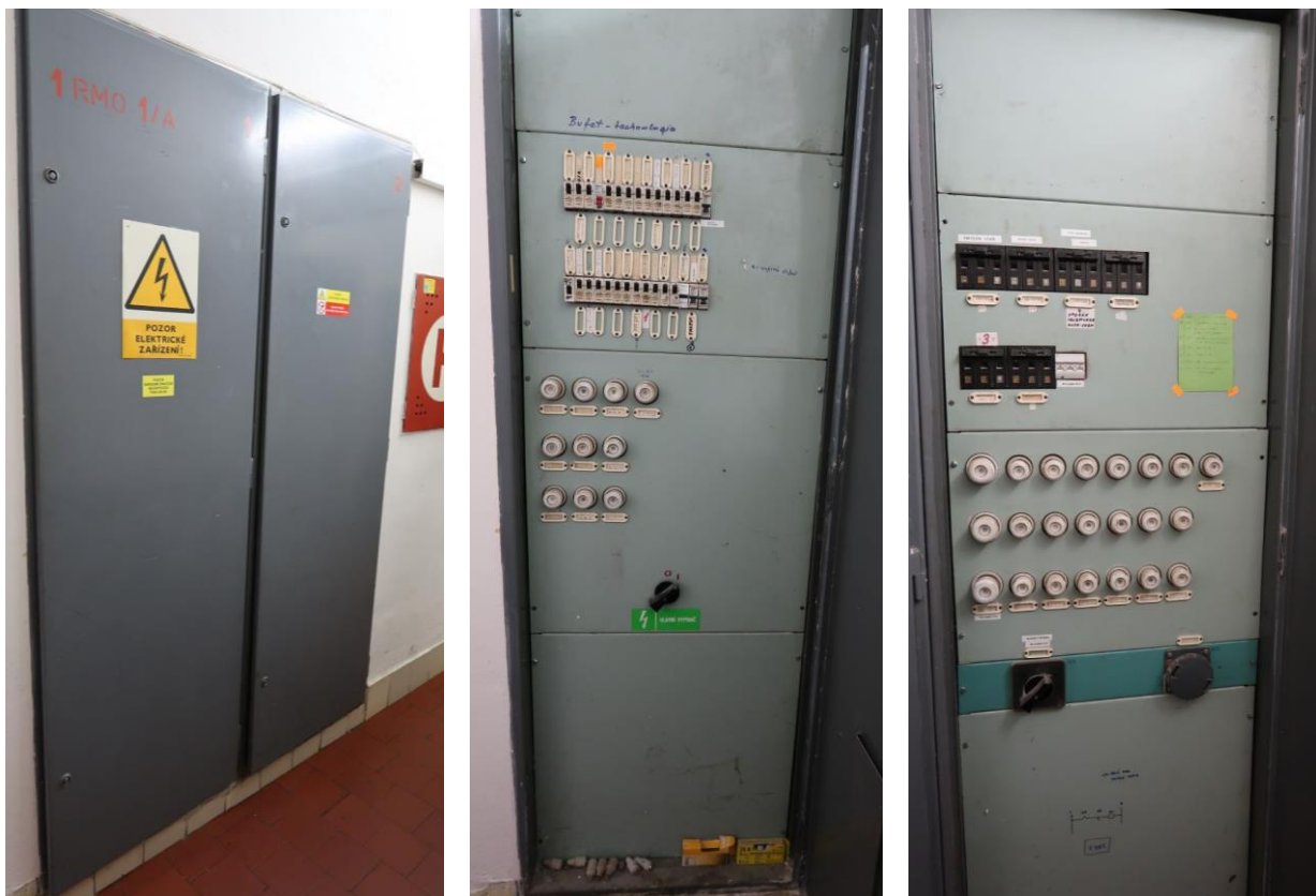
Podružný rozvaděč 1RMO 3/B (1.NP) – výstroj a výzbroj
