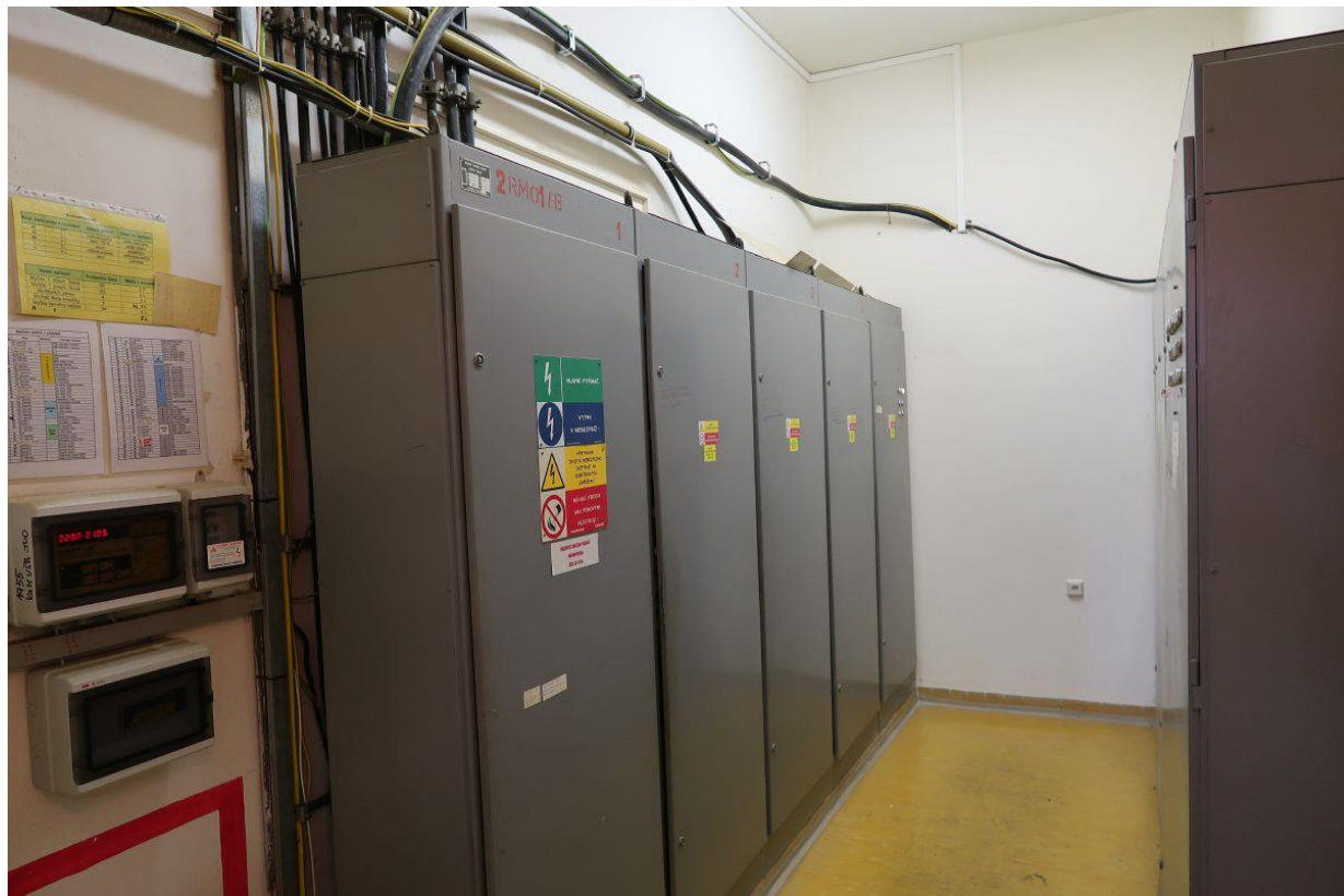
Podružná rozvodna 2RMO 1/B a 2RMO 2/B – podružné rozvaděče / ovládání VZT
