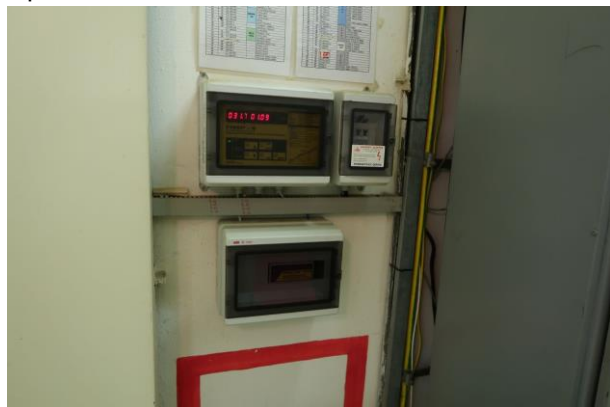
Podružná rozvodna 2RMO 1/B a 2RMO 2/B – podružné rozvaděče / ovládání VZT
