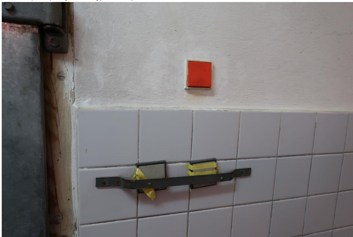
Chodba (1.NP) – vyřazení vypínačů z provozu
